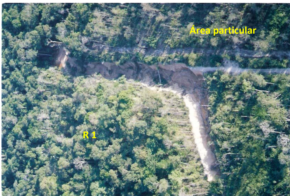
Figura 21: Imagem aérea da voçoroca nas limitações da R-1, Sinop-MT, 2002 (Fonte: Colonizadora Sinop).
