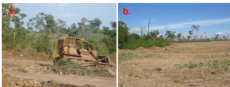
Figura 20: a) Maquinário aterrando voçoroca, 2008; b) Aterro de erosão com terra e entulhos, 2009 (Fotos: RAUBER).
