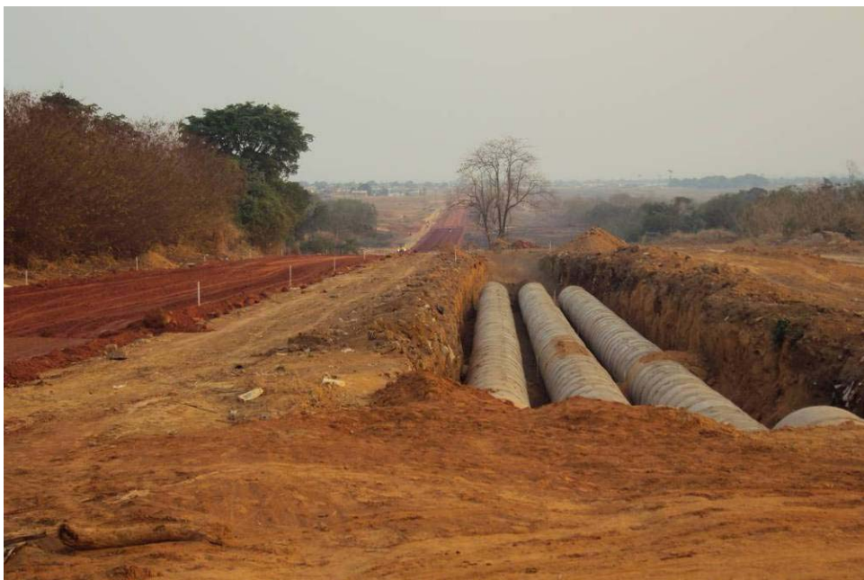
Figura 35: Canalização e início da pavimentação da Avenida das Itaúbas no trecho que fragmenta o Parque Mun. Jardim Botânico (Foto: RAUBER, 2010).
