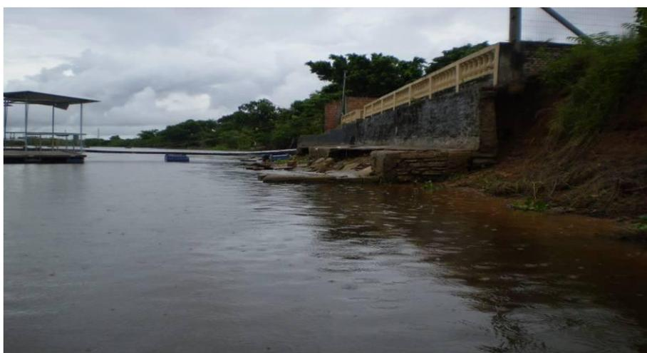
**Figura 20:** Dragagem de areia, muro de arrimo em processo de erosão, trecho 03
