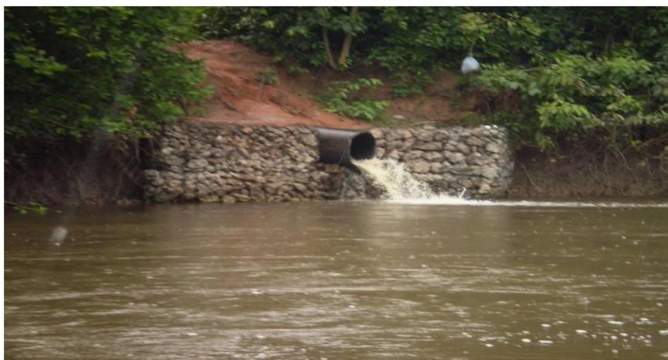
**Figura 28:** Ponto de lançamento de efluentes industriais, trecho 04
