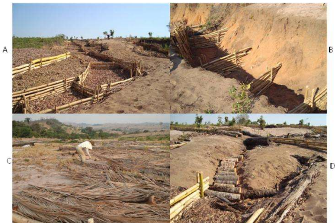
Figura 30: Paliçadas laterais ( Bambusa sp.), folhas de coqueiros ( Orbignia sp.) cobrindo o solo e paliçadas de fundo com troncos de coqueiro ( Orbignia sp.) (Fonte: BARROS, 2010).
