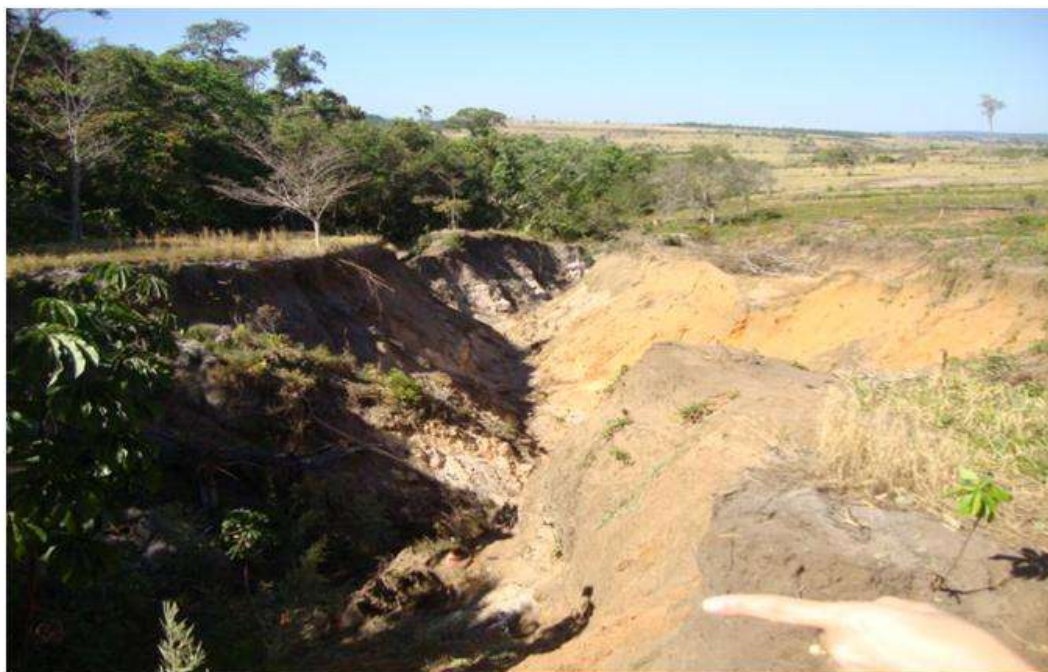
Figura 5: Voçoroca no córrego Queixada - bacia do Córrego Dracena. (Foto: Edna de Laet).
