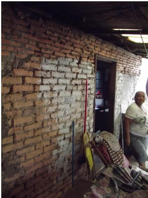
**Figura 5** – Aspecto de parede feita de tijolão
