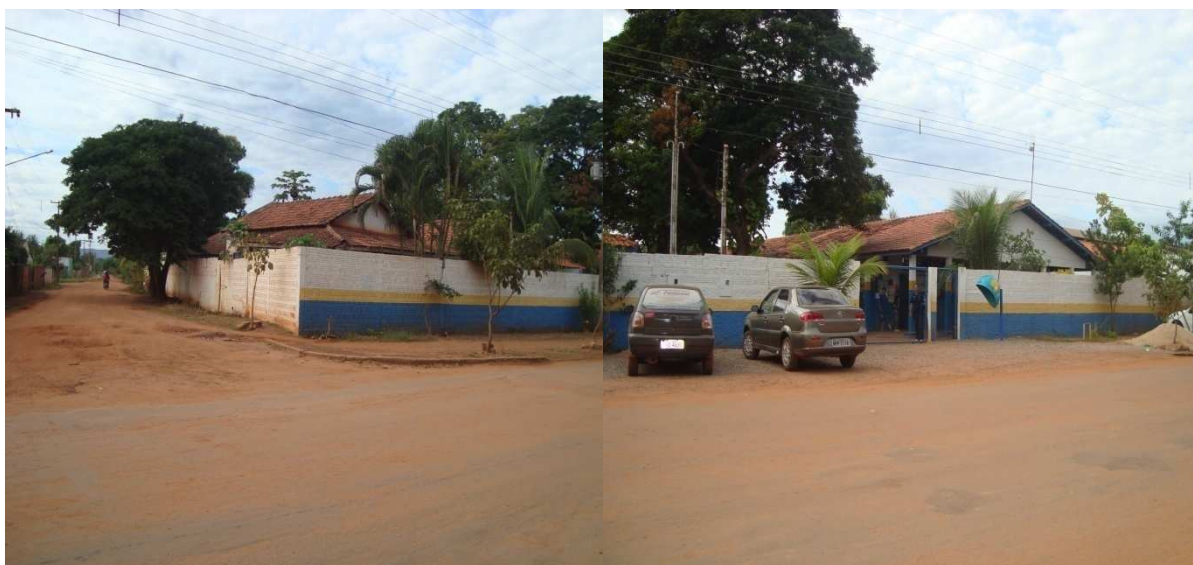
Figura 19: Fachada escola E/D
