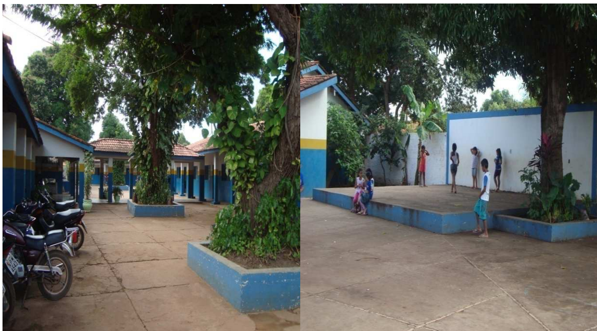
Figura 20: Pátio interno da escola E/D
