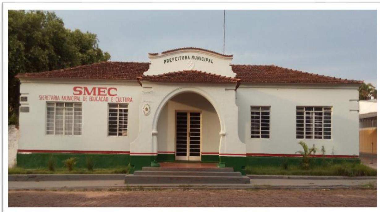
Figura 11 - Foto da fachada principal da Smec de Barra do Bugres.
