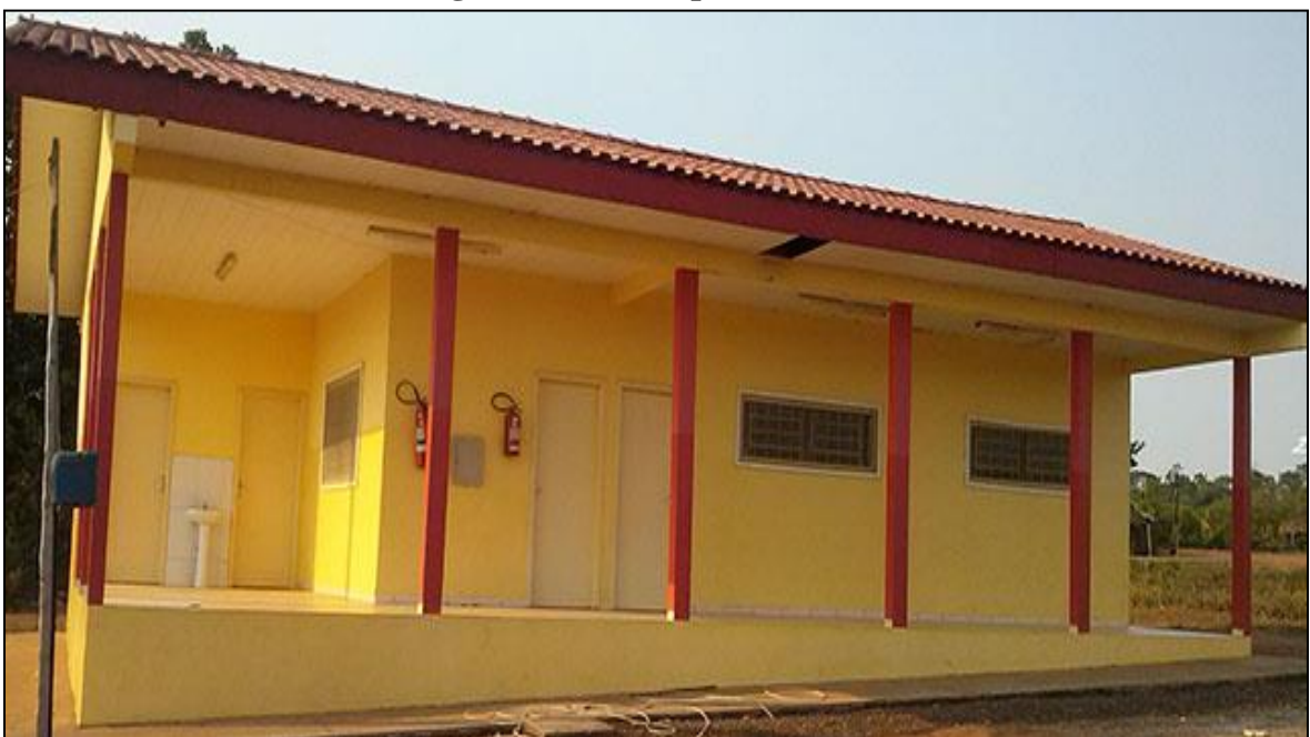
Figura 8 – Escola parte exterior
