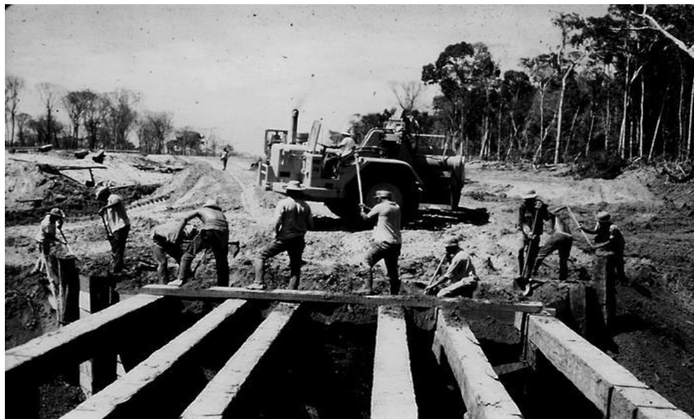
Figura 3 - Abertura BR 163 com máquinas trabalhando
