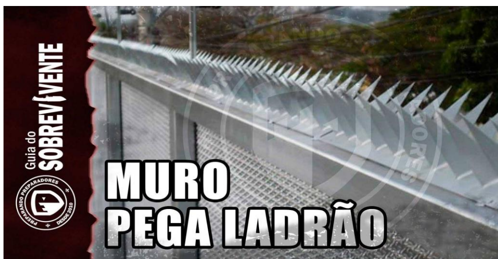
Figura 7 Muro com ponta de lança 11
