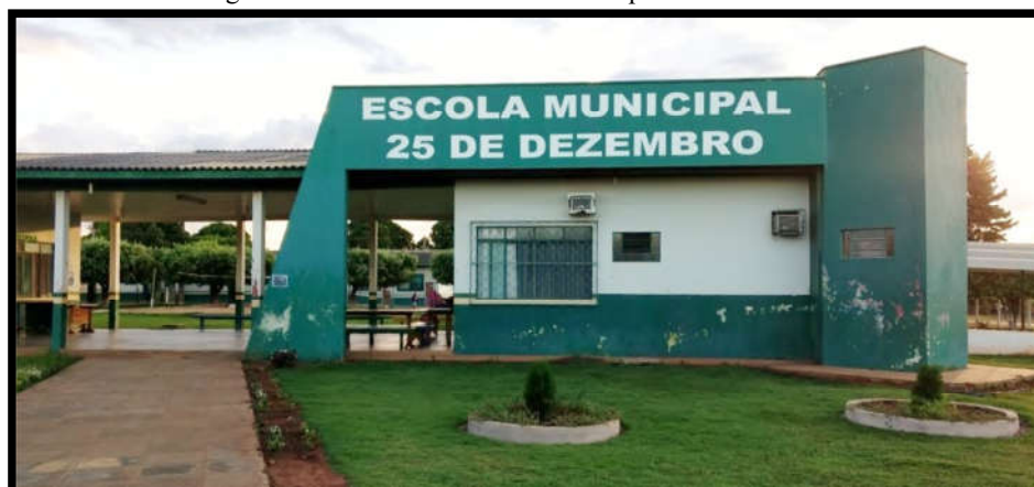
Figura 13 – Fachada da Escola Municipal 25 de Dezembro
