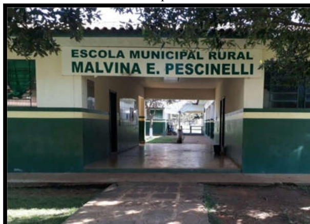
Figura 22 – Fachada da Escola Municipal Rural Malvina Evaristo Pescinelli
