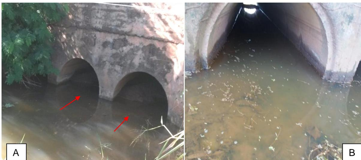
(A) Acúmulo intenso de sedimentos na manilha (08/2016); (B) Ausência do acúmulo intenso de sedimentos na manilha (06/2017).
