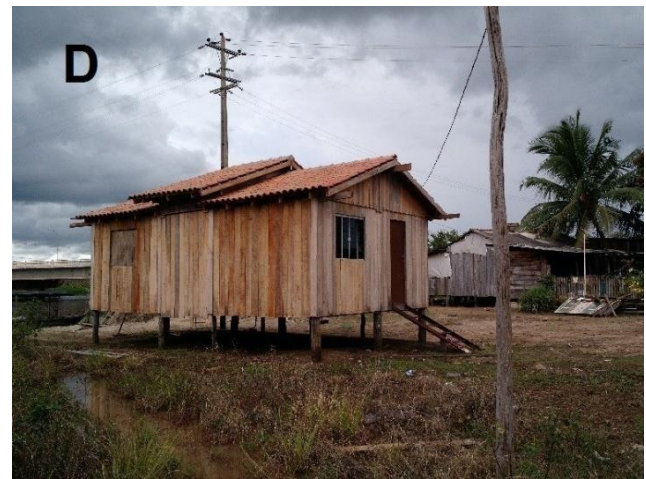
Foto D: casa pronta, "obra finalizada"
