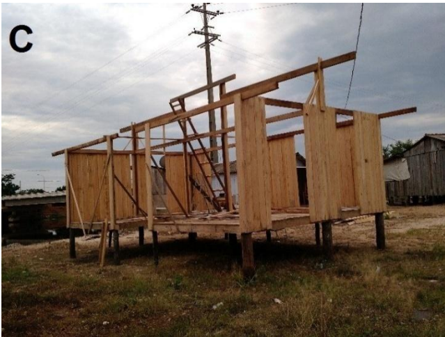
Foto C: paredes e estrutura do telhado em Construção.
