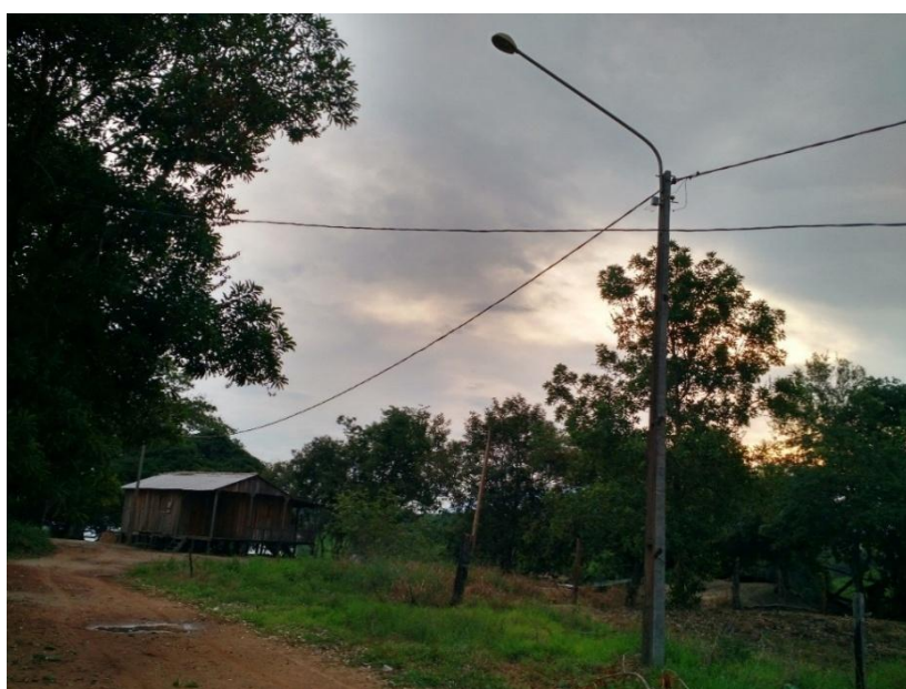
Figura 29: Instalação de postes e rede elétrica na Vila dos Pescadores
