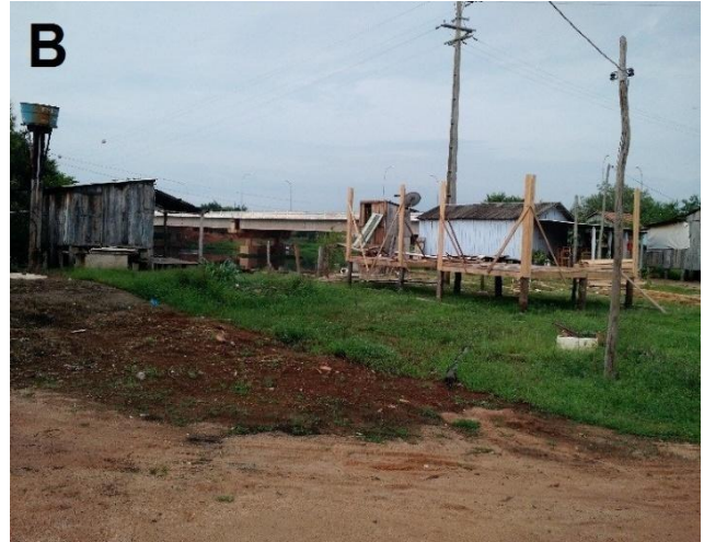
Foto B * erguimento das paredes
