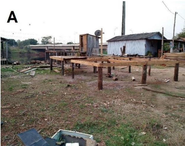
Foto A: escolha do terreno, estrutura inicial/base
