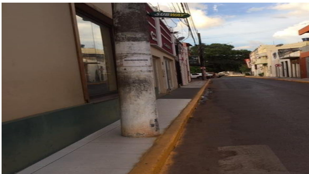
Figura 48 - Calçada estreita na Rua Coronel Farias
