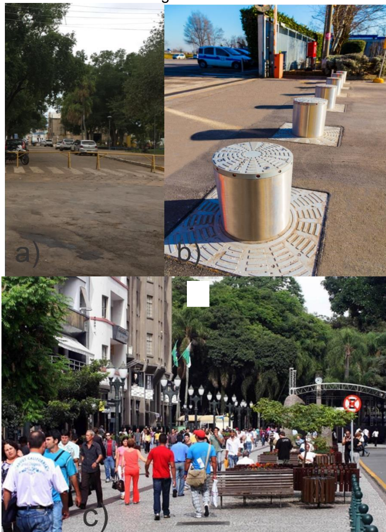
Figura 65 - A, B e C: modelos de barreiras móveis (" bollards ") para restrição de tráfego de veículos
