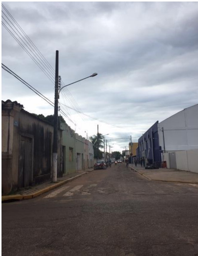
Figura 56 - Rua Marechal Deodoro
