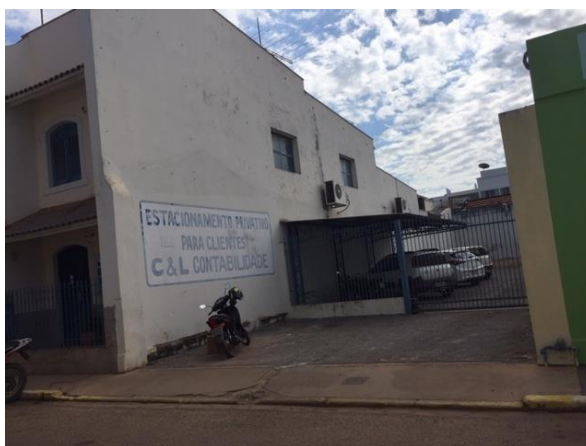
Figura 61 - Estacionamento localizado na rua Antônio Maria
