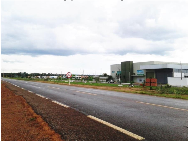
Foto 5 – Barão do Melgaço III visto da margem da Br-174 sentido Vilhena
