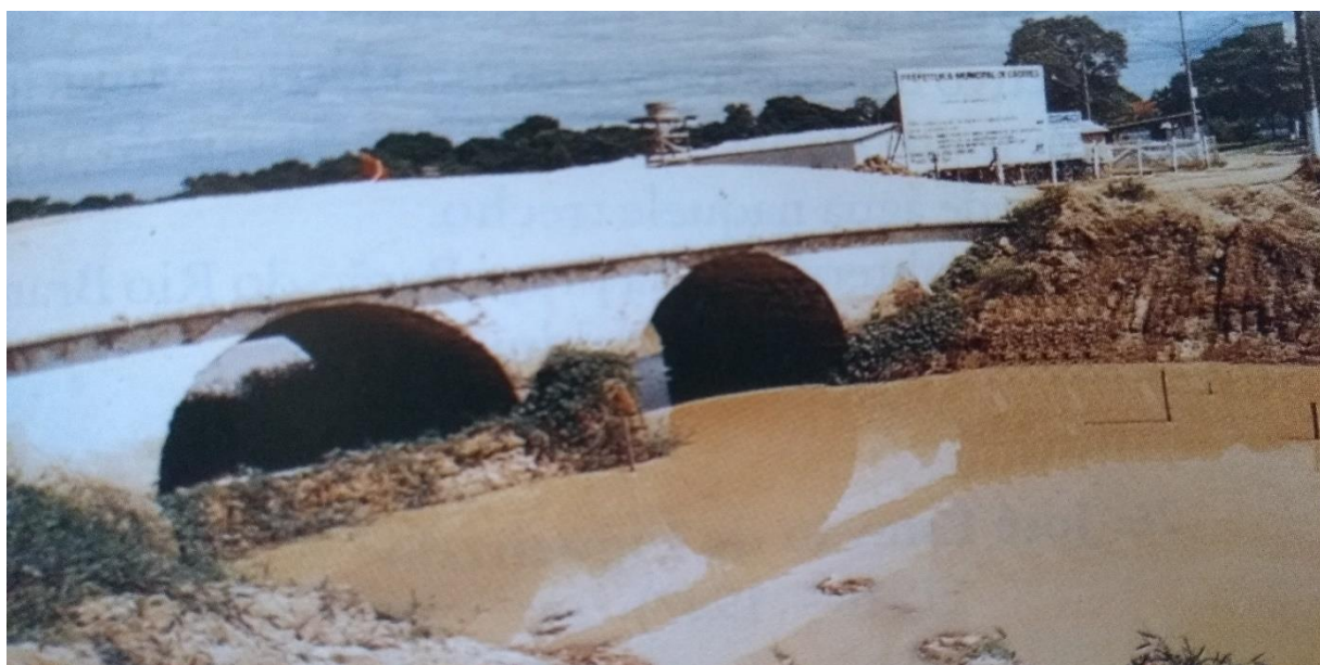
Figura 24 - Ponte Branca, Cáceres/Mato Grosso
