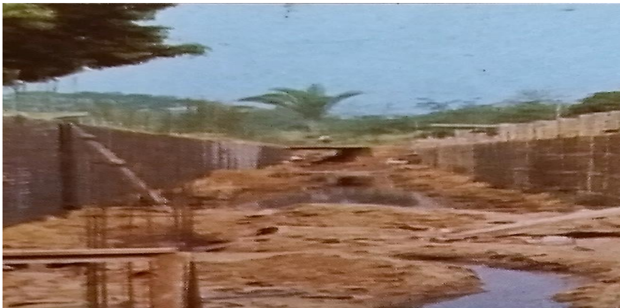
Figura 23 - Obra de canalização do córrego Sangradouro, Cáceres/Mato Grosso
