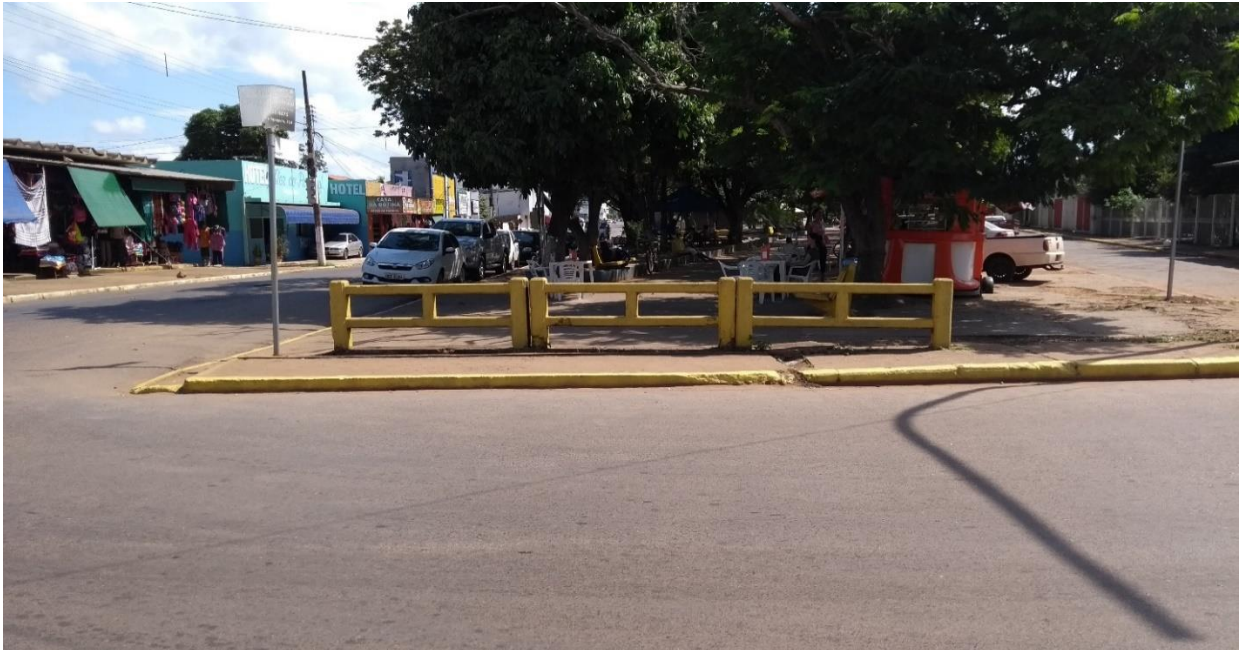
Figura 17 - Ponto 7 - Córrego Sangradouro, trecho retificado, Centro - Cáceres/Mato Grosso (2017)
