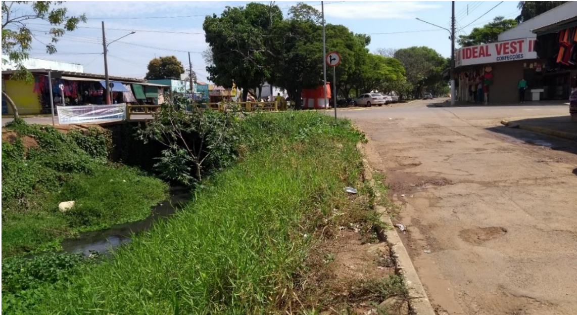
Figura 16 - Ponto 7 - Início do trecho canalizado do córrego Sangradouro, Centro - Cáceres/Mato Grosso (2017)
