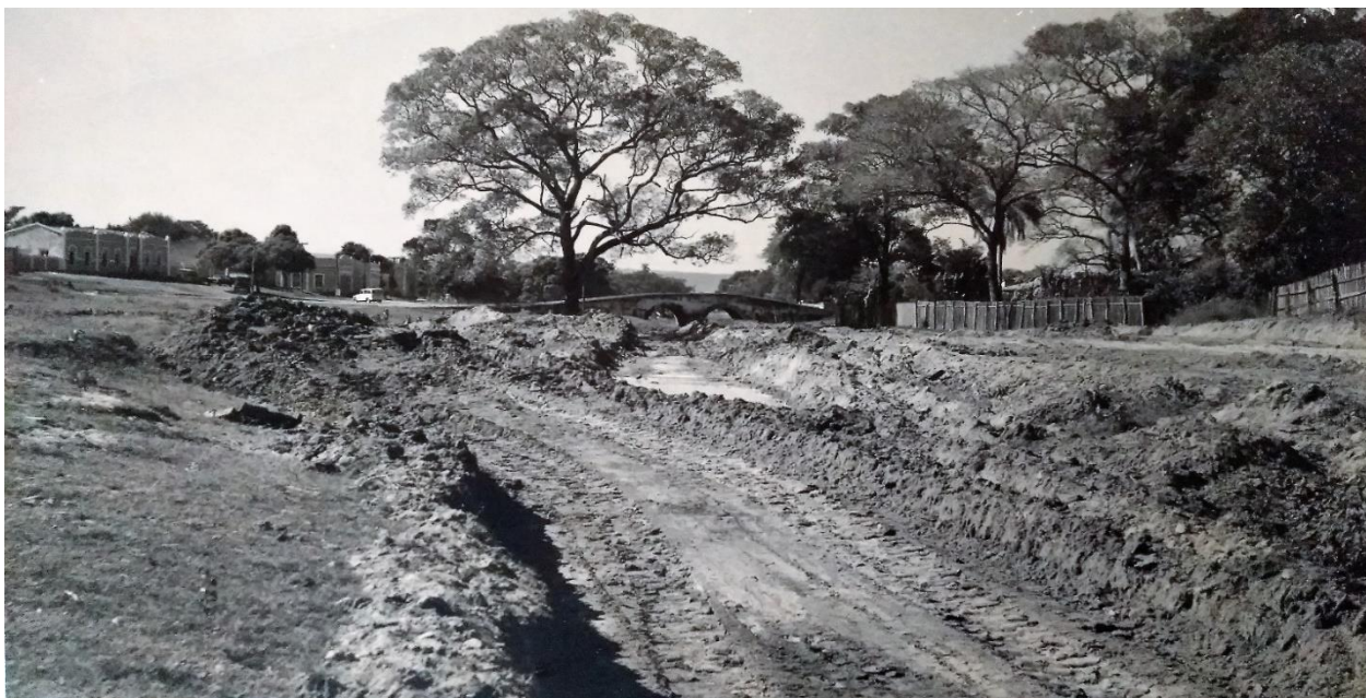
Figura 22 - Obras de retificação do córrego Sangradouro – Cáceres/Mato Grosso
