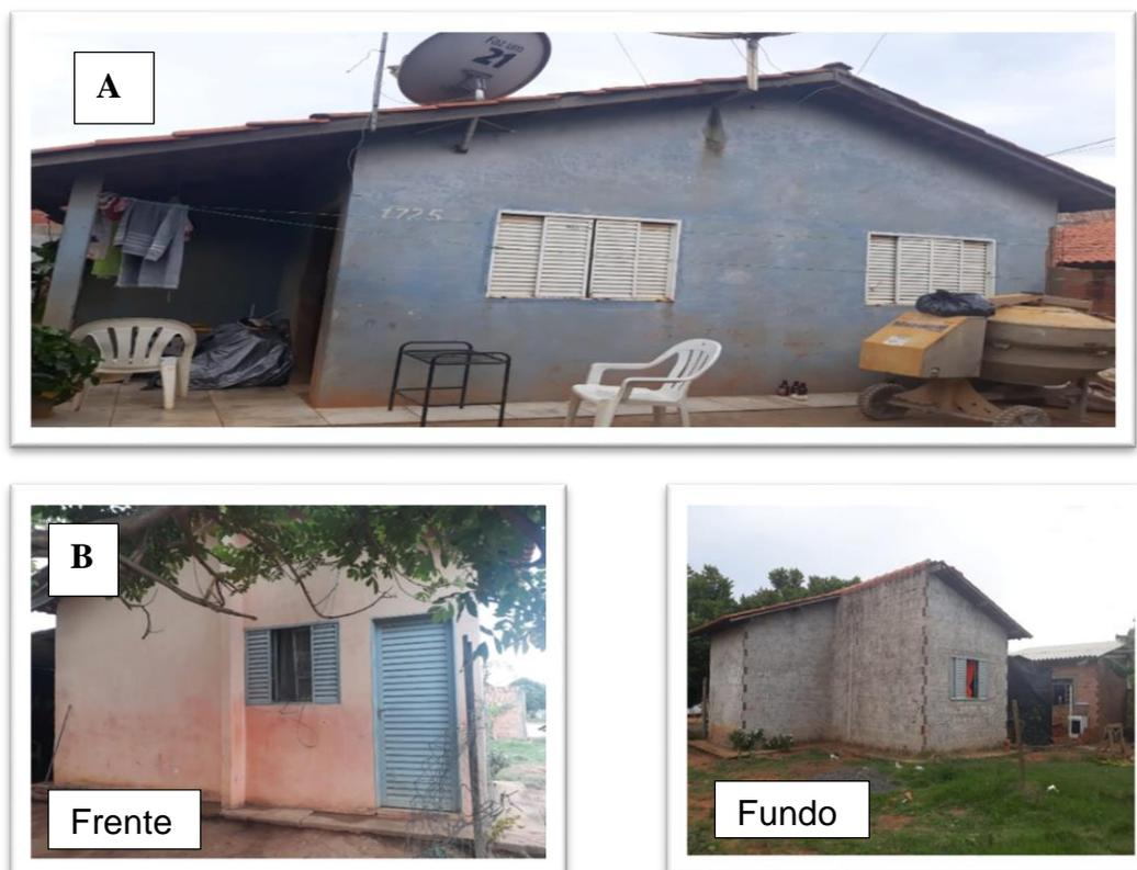
O terreno dessas moradias são de 320 m<sup>2</sup> e a área construída de 27,87 m<sup>2</sup>, contendo dois quartos, sala e cozinha conjugadas, e um banheiro. As residências foram entregues sem forro, só no contrapiso, sem cerâmica, e com reboco nas paredes do lado de dentro e parte do lado de fora, conforme pode-se ver na imagem.
