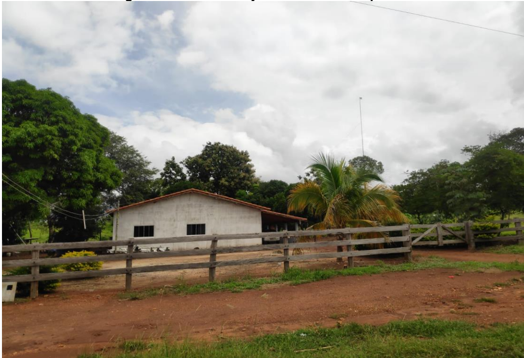
Figura 13 – Casa com janela de vidro temperado
