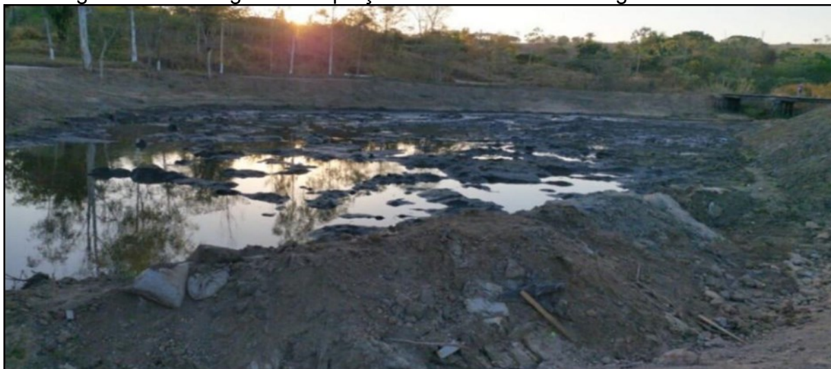
Figura 28 – Barragem de captação e abastecimento de água de Jauru/MT
