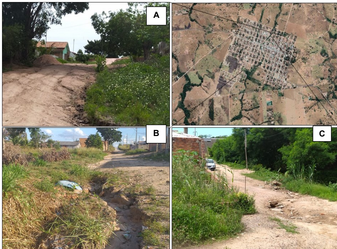
Figura 24 – Processos erosivos nos bairros: A) Ipiranga; B) Cidade Nova; C) Centro, Jauru/MT
