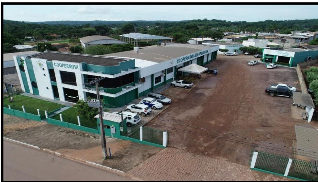
Figura 23 - Sede Administrativa da coopernova em Terra Nova do Norte-MT
