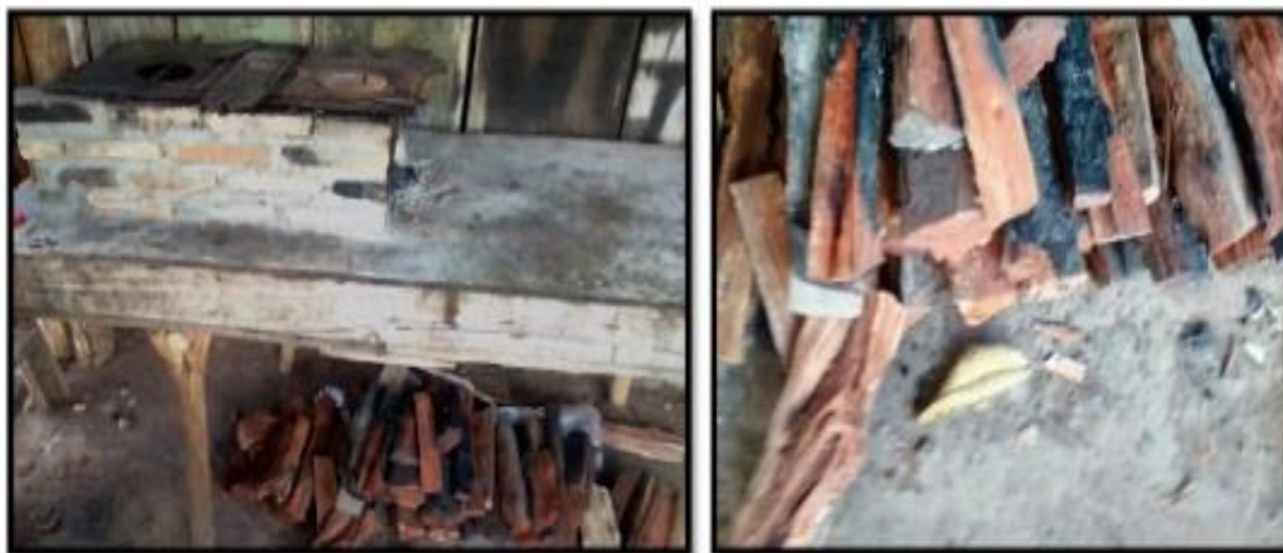
Figura 13 A: Fogão de lenha construída com cimento e tijolo; B: lenha utilizada no fogão
