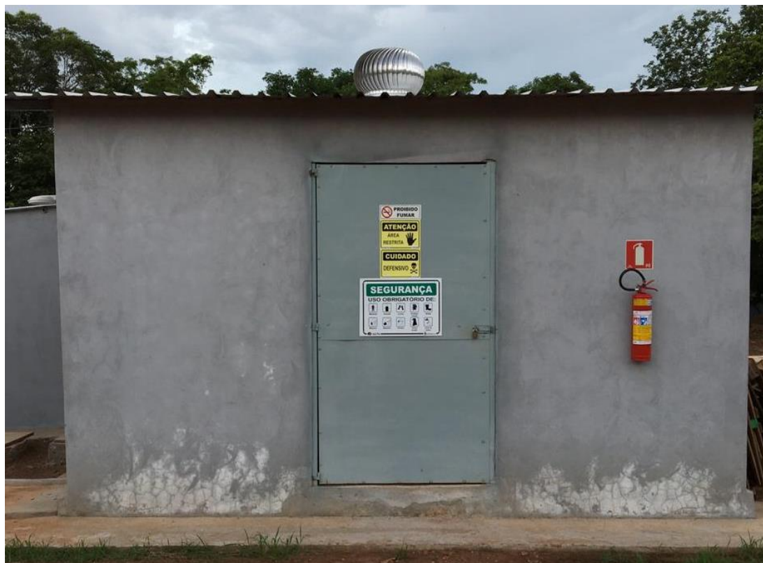
Figura 8 Depósito de armazenamento dos agrotóxicos, na fazenda Lagoa Dourada, Poconé-MT
