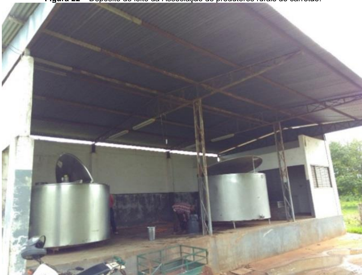
Figura 22 – Depósito de leite da Associação de produtores rurais do Carretão.
