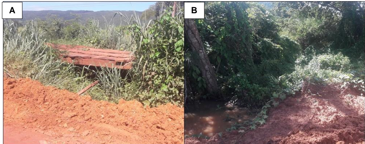
Figura 18. Aterro realizado no canal principal para a construção de uma ponte na rodovia MT-343
