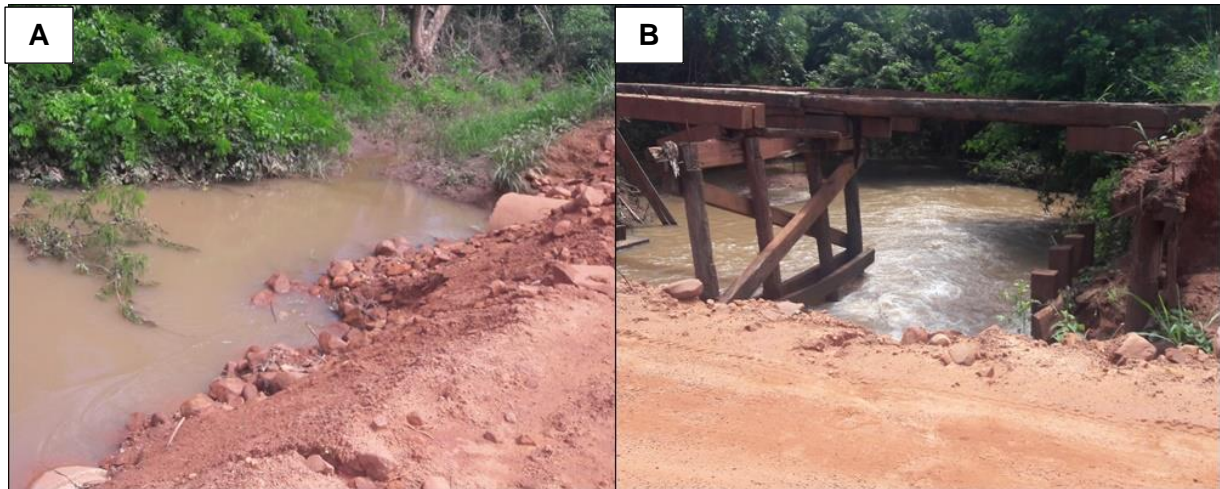
Figura 24. Processo de terraplanagem para construção de um segmento da rodovia MT-343
