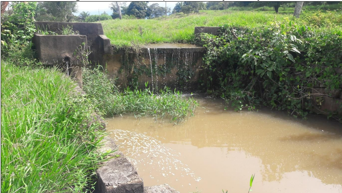
Figura 13. Barramento para a construção do açude
