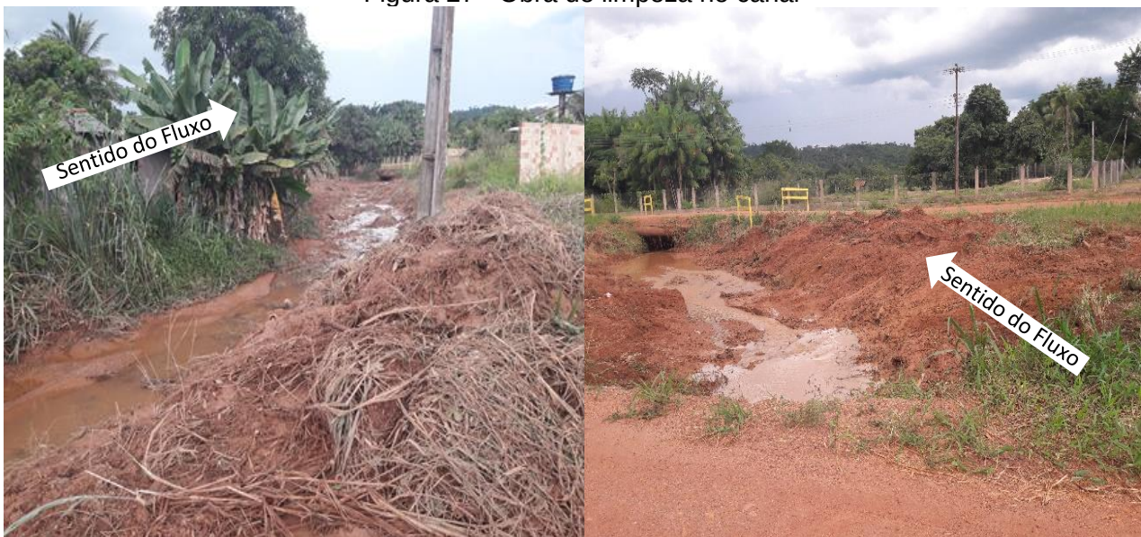
Figura 27 - Obra de limpeza no canal
