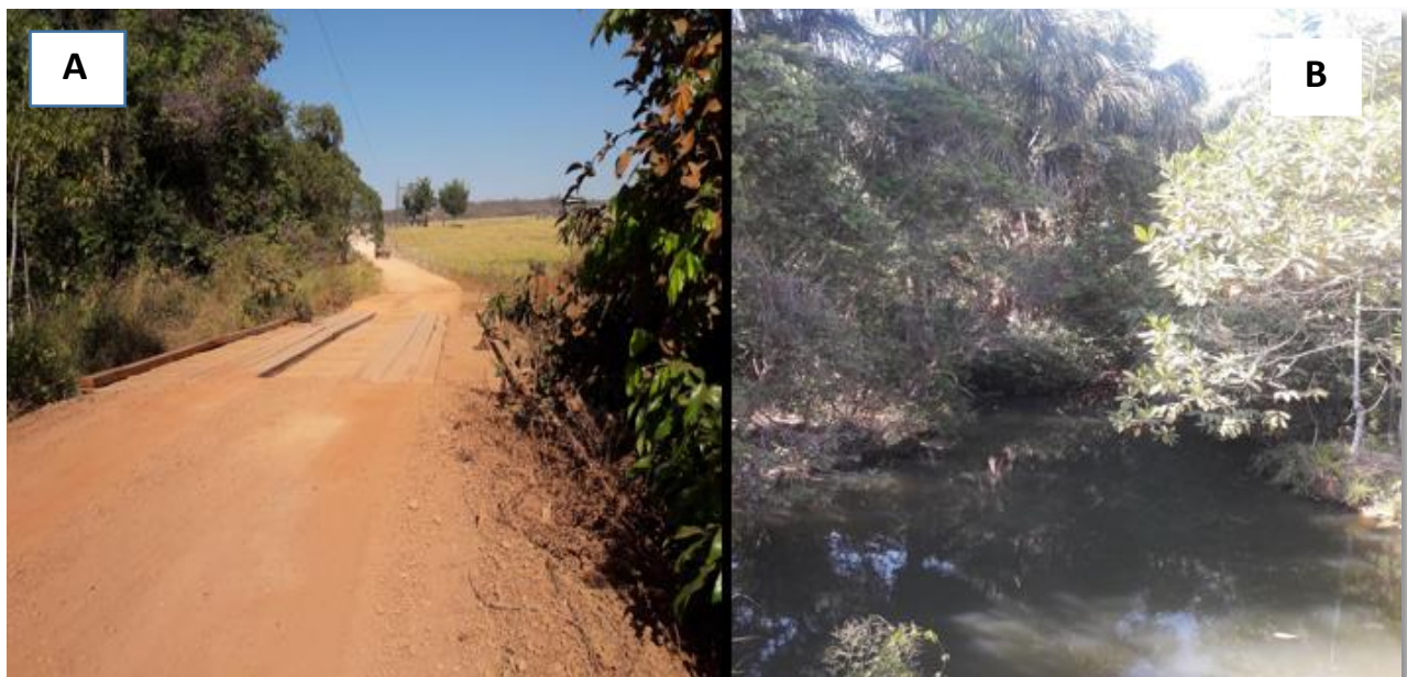
Figura 30 - Ponte acesso parque florestal
