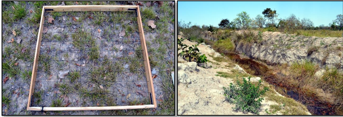
Figura 7. Visão local e panorâmica da cobertura do solo e de canal de drenagem na Mancha B de Campos de Murundus do Município de Vila Bela da Santíssima Trindade – MT.
