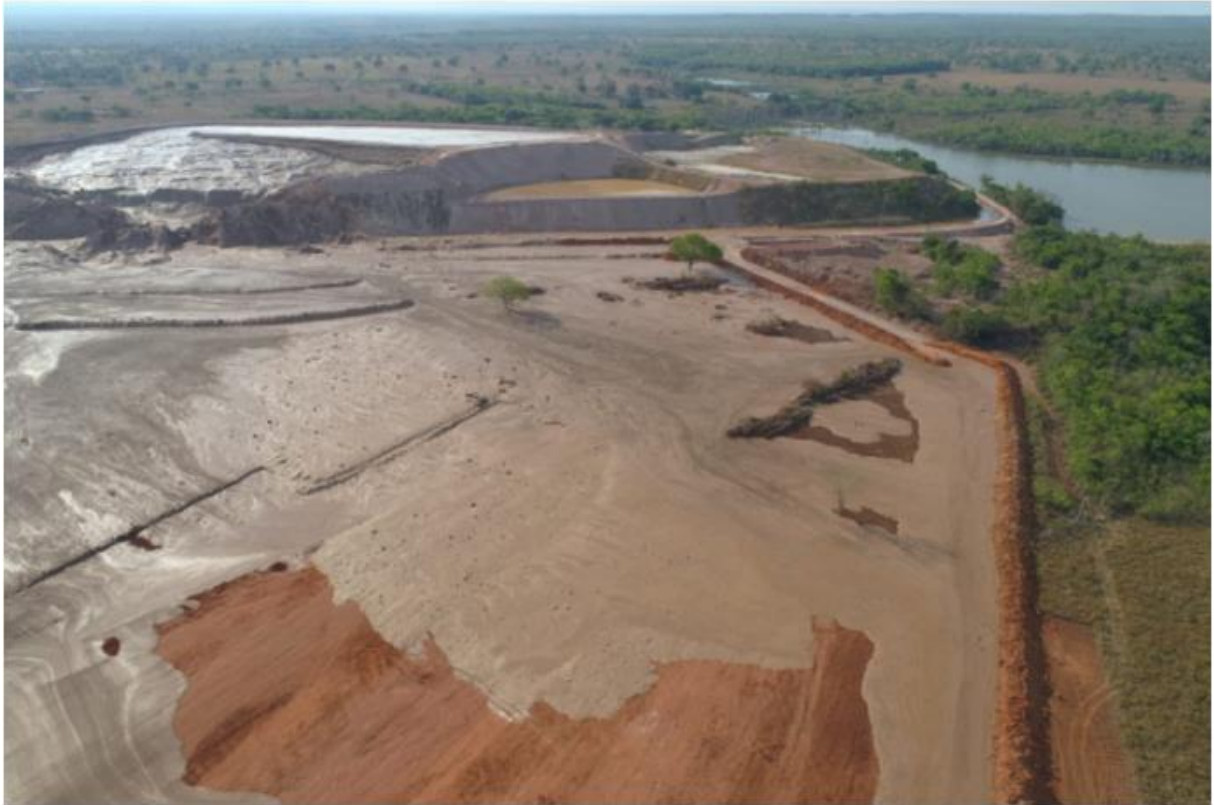
Figura 9 - Rio de rejeitos após o rompimento da barragem TB01, em Nossa Senhora do Livramento/MT
