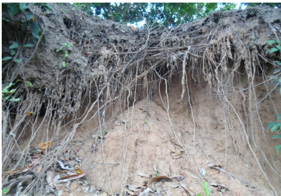
Figura 47 - Seção II no córrego Salobra, em Porto Estrela, MT, após dez meses, remoção de sedimentos no porte superior da margem côncava em 2013.
