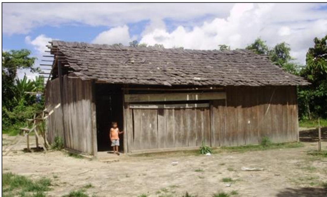
Figura 4 - Uma das salas anexas da aldeia Jatobá.
