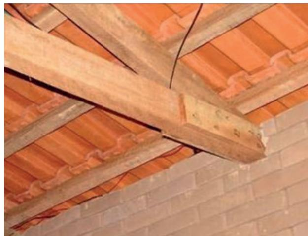
Figura 11 – Interface entre alvenaria e cobertura: observar a ausência do berço.
