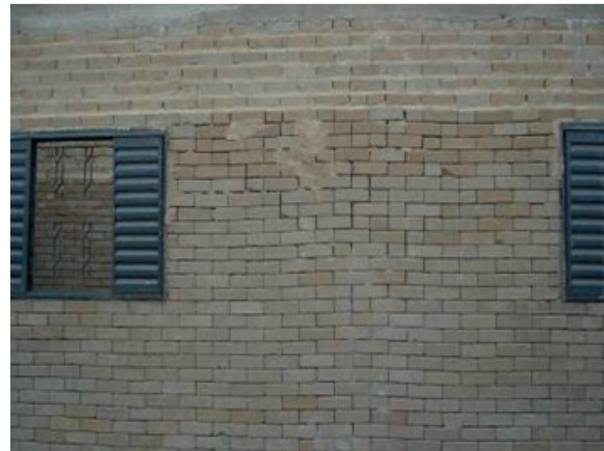
Figura 17 – Falha no alinhamento das paredes
