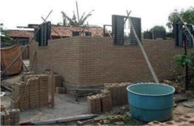
Figura 14 – Fiadas levadas por igual: a técnica foi executada corretamente
