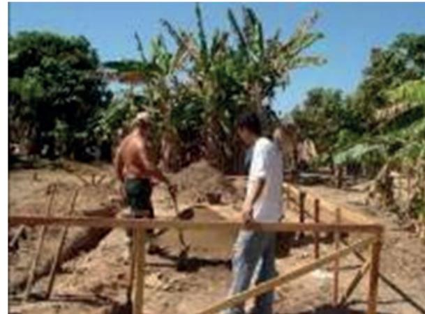
Figura 05 – Etapa de locação e escavação para execução das fundações
