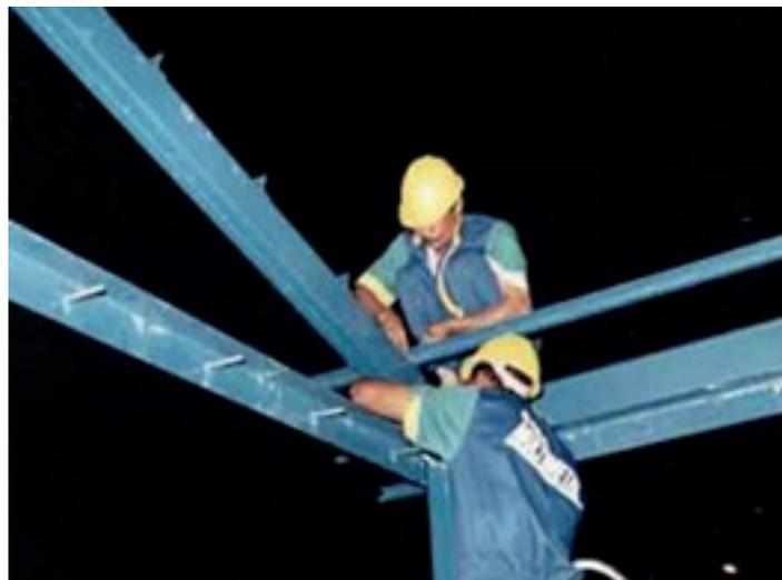
Figura 9 – Montagem das terças metálicas.
