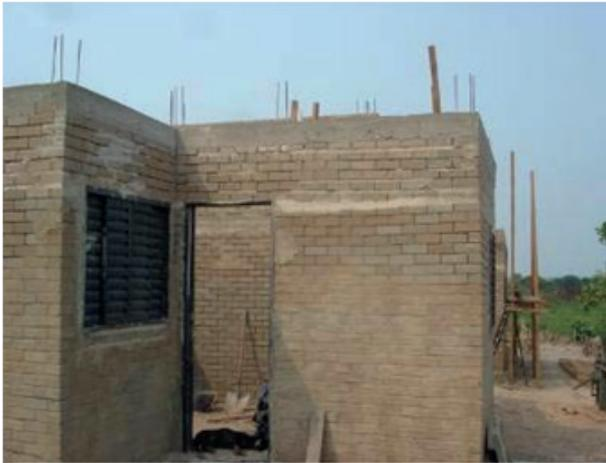
**Figura 07 – Alvenaria, com cinta de concreto armado no nível de respaldo superior**
