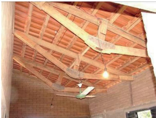
Figura 13 – Detalhe das instalações elétricas: observar os fios pendurados na estrutura de cobertura.
