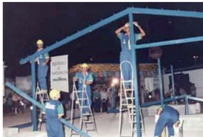
Figura 10 – Fixação das tesouras e vigas.
