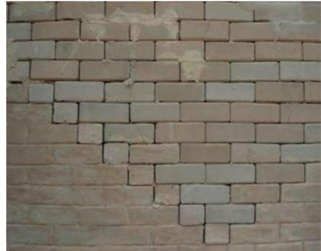
Figura 16 – Uso inadequado dos meiotijolos
