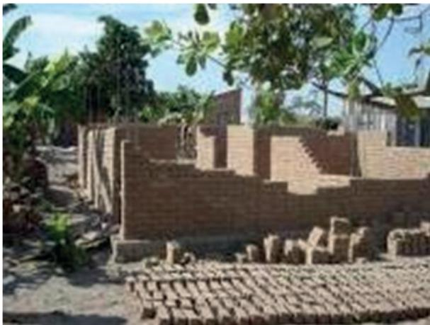
Figura 06 – Execução da alvenaria do painel de fechamento
