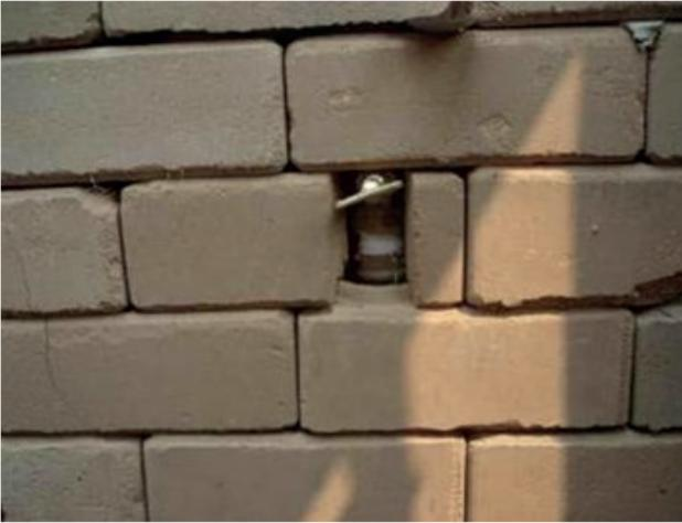
Figura 12 – Detalhe do registro e do tubo passando dentro do tijolo: observar que o registro está muito embutido na parede dificultando a operação
