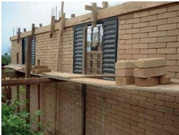
Figura 09 – Interface entre alvenaria e esquadria
