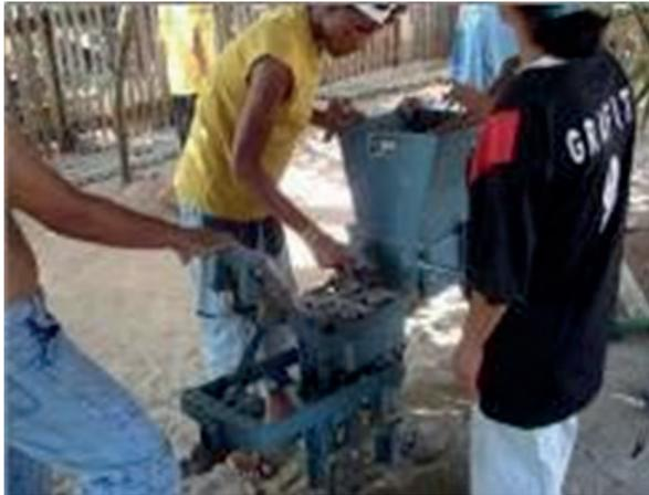
Figura 03 – Produção dos tijolos pelos moradores: moldagem dos tijolos de solo-cimento com a utilização de prensa
