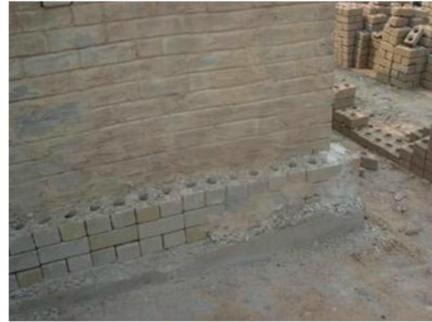
**Figura 08 – Interface entre fundação e alvenaria: parede com 20 cm de largura (01 vez)**
