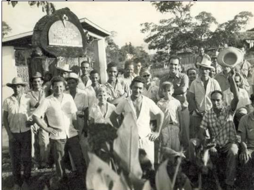
Figura 9 - Edificação da primeira praça central da gleba Rio Branco
