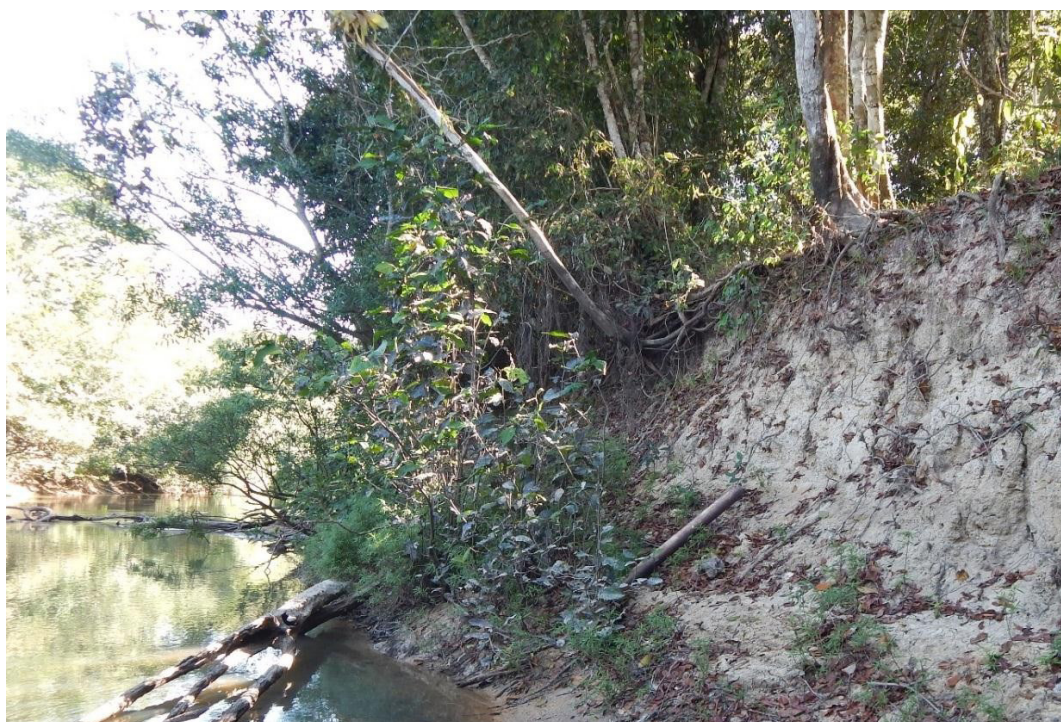
Figura 76 – Erosão por solapamento basal. Rio Carapá, Nova Canaã do Norte 2016.
