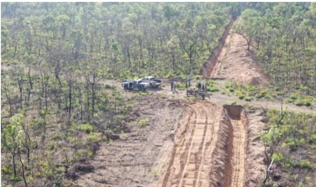
**Figura 5- Fotografia aérea de dreno em construção, após fogo em vegetação nativa.**
