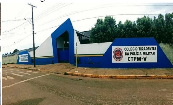
Figura 2 - Fachada da escola
