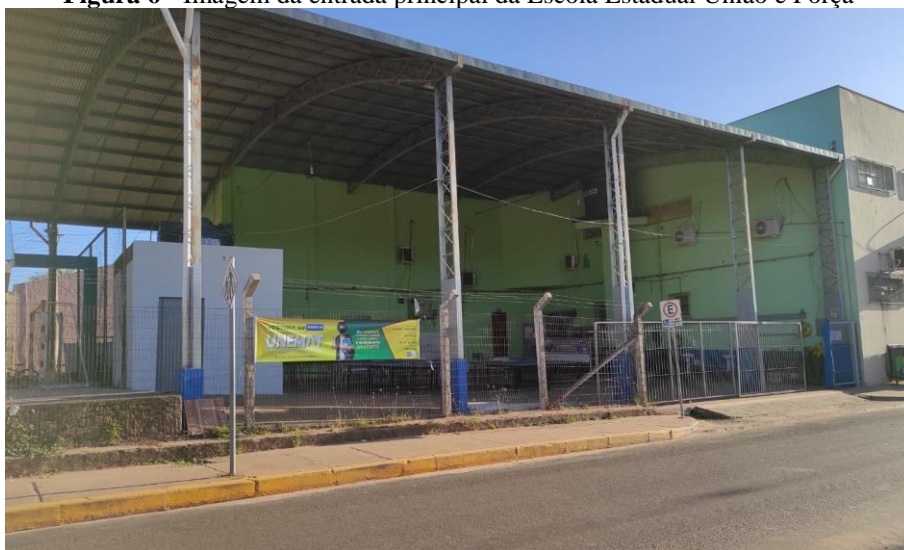
Figura 6 - Imagem da entrada principal da Escola Estadual União e Força
