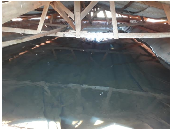
Imagem 10: Reservatório de água
